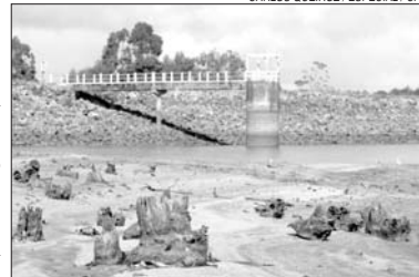
Nível do reservatório baixa 2 centímetros por dia
