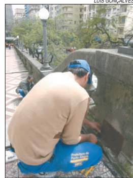
Prefeitura repôs iluminação de viaduto
